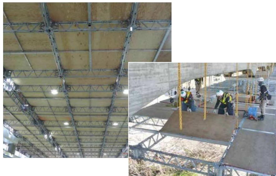
システム足場の一例
