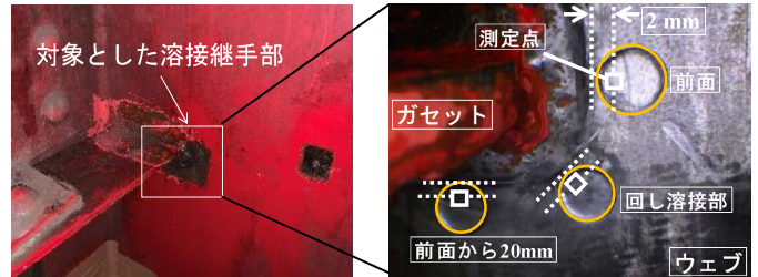
図-1 実橋梁における残留応力測定箇所
