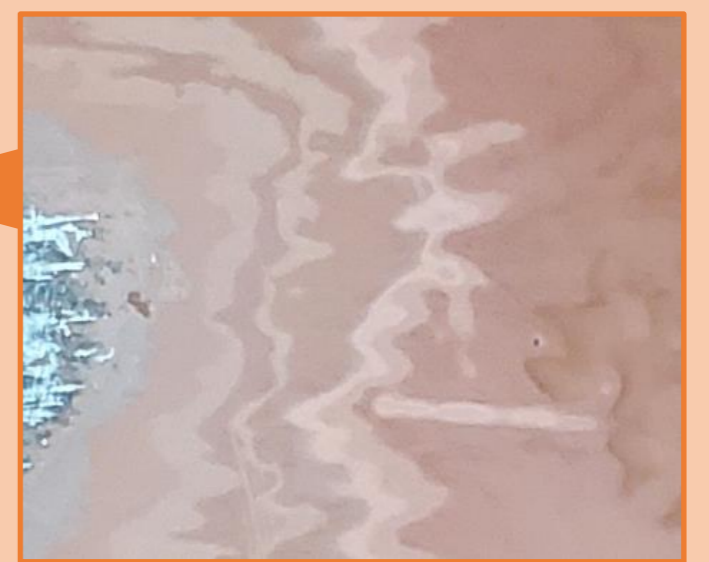
塗膜除去前に刷り取りにより確認した塗膜層の様子
