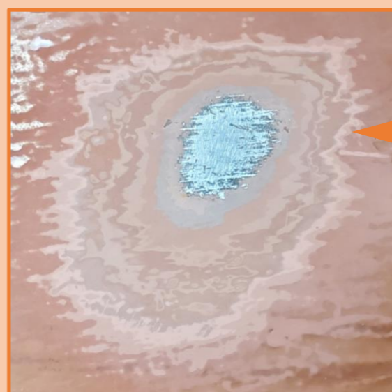
塗膜除去前に刷り取りにより確認した塗膜層の様子
