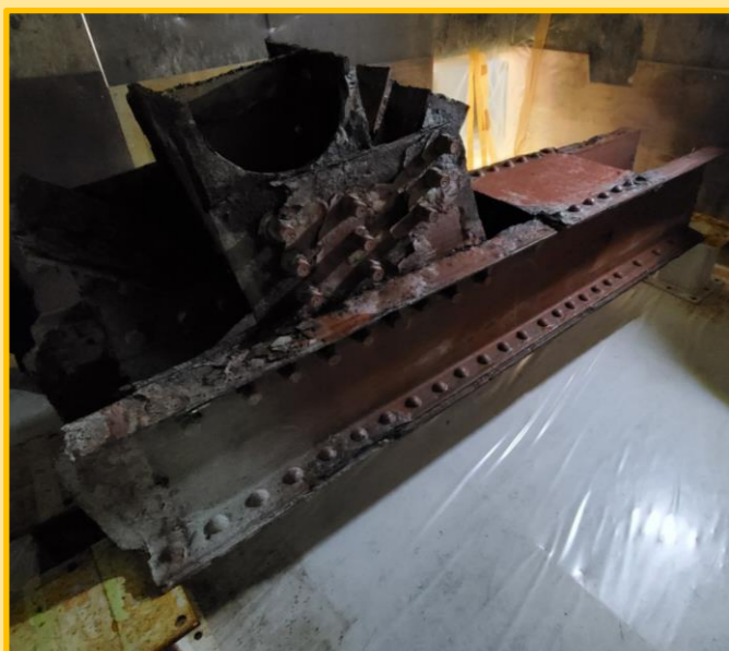
塗膜除去前の様子
