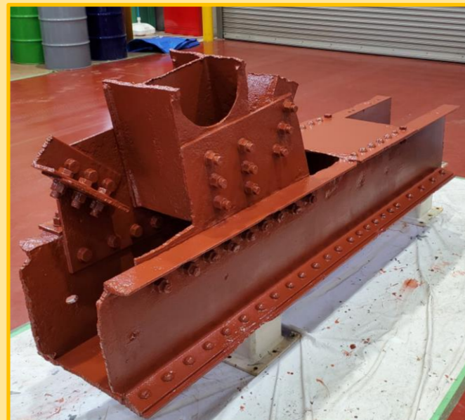
塗装完了後の様子
